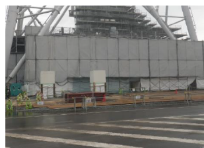
③ 試薬建屋入口から 北側を撮影
