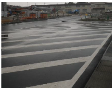
① 試薬建屋入口から 東側を撮影
