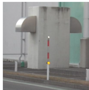
洞道の排気口
