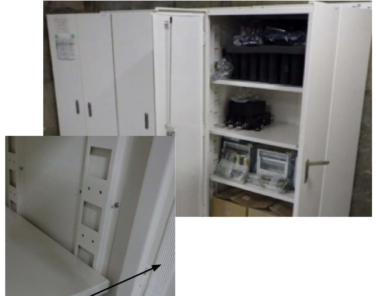
本体と扉の間隙に耐熱ガラス繊維を施工
