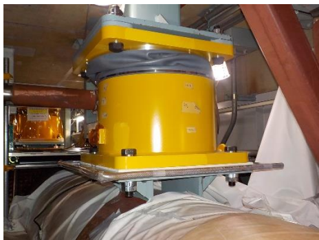
図 5-2 島根 2 号機の配管系に設置した三軸粘性ダンパの外観及び構造
