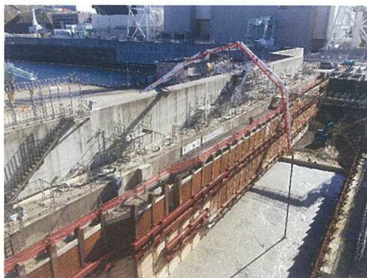
現地打設状況
