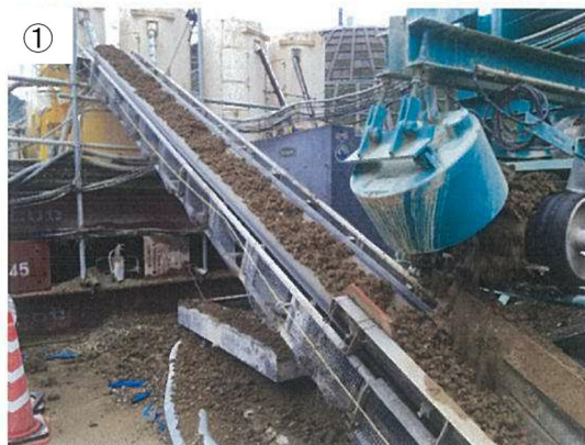
① ベルトコンベア(土砂供給状況)
