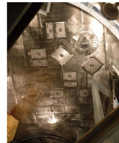
図 1-3 コリウムシールド外観
