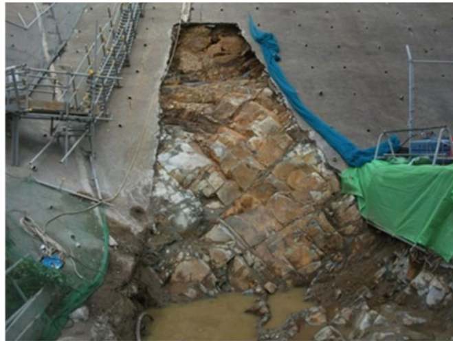
图 1.2—10 防波壁東端部 岩盤露出状況
