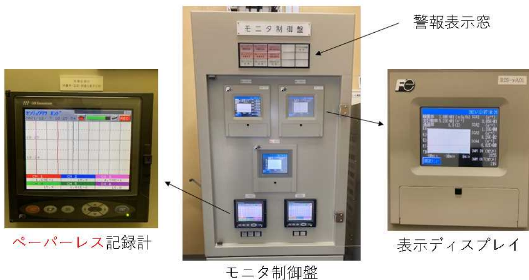
第8-2図 モニタ制御盤の警報表示窓と表示ディスプレイ
