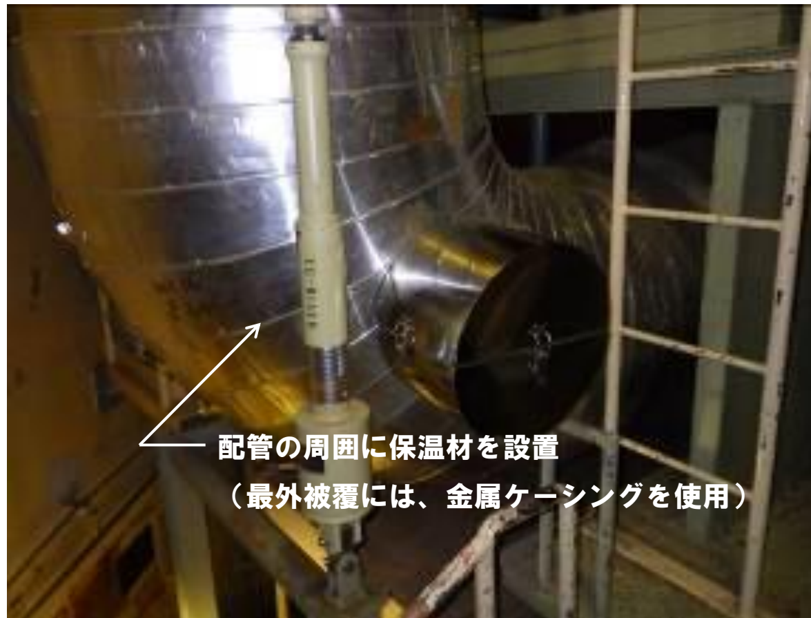
一例：1次主冷却系の配管
