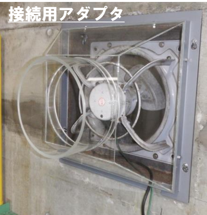
接続用アダプタとフレキシブルダクトの接続状態
