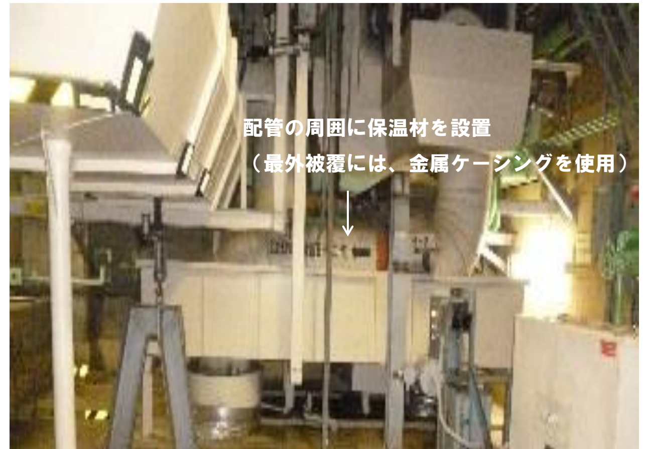
一例：2次主冷却系の配管
