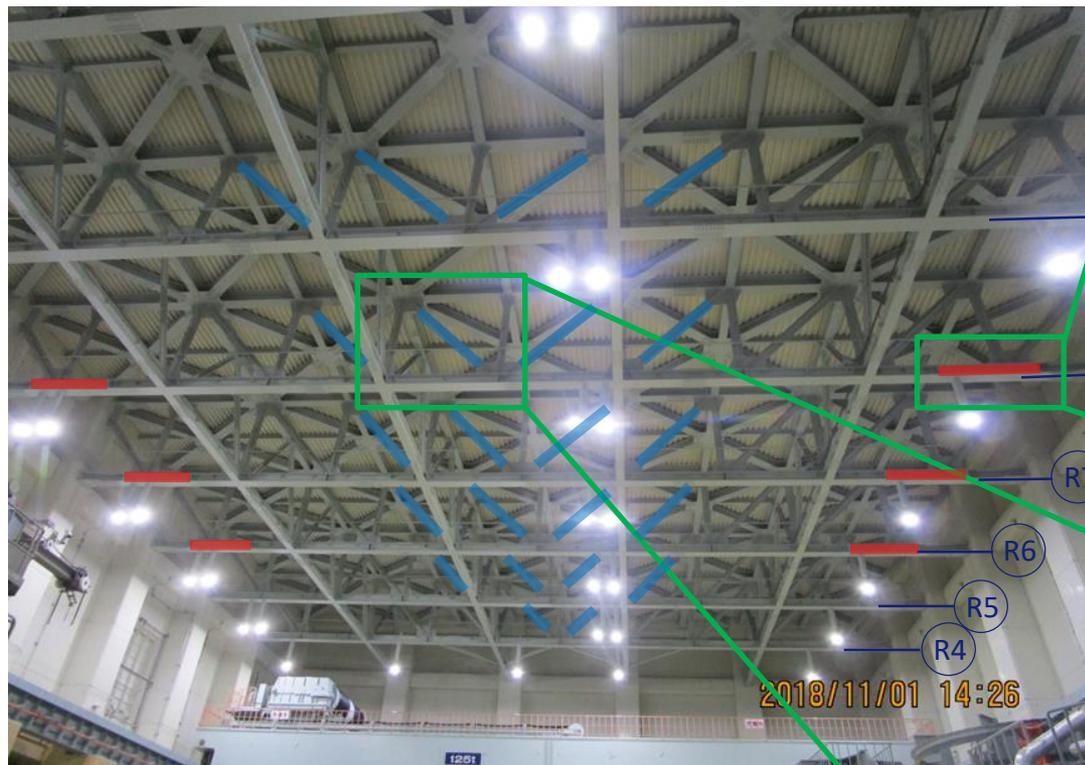
2号R/B屋根トラス (全景) 西側から撮影 ※主トラスの補強箇所に着色
