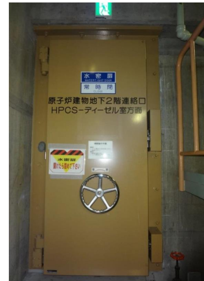
水密扉の設置状況
