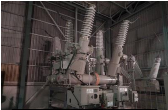
ガス絶縁複合開閉装置 (GCS)
