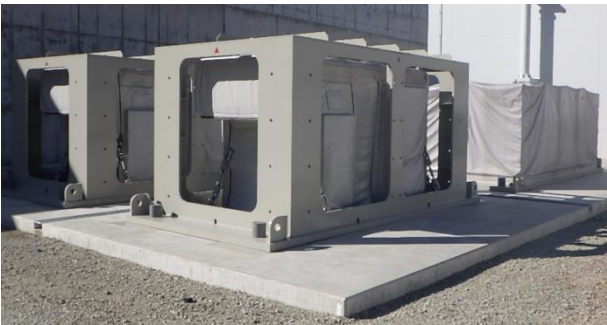
空気浄化送風機及びフィルタユニット
