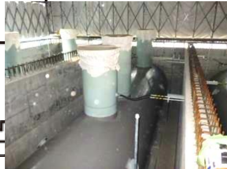
B系燃料貯蔵タンク外観 (据付段階)
