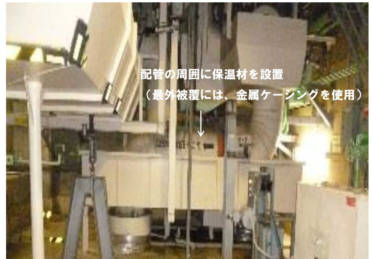
一例：2次主冷却系の配管
