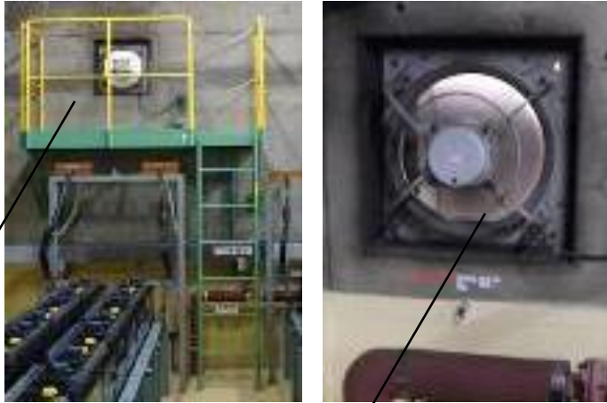
可搬式 局所排気装置 接続位置
