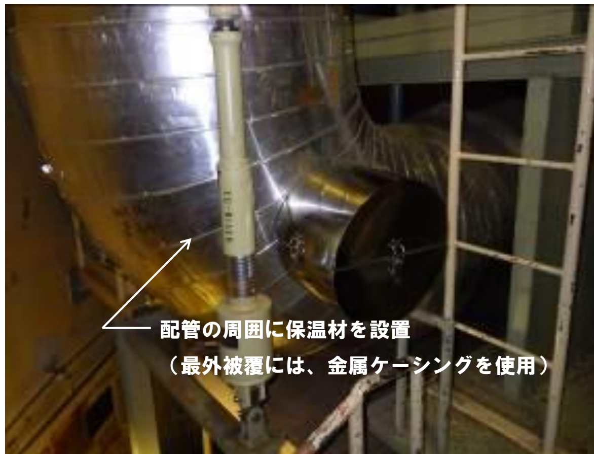
一例：1次主冷却系の配管
