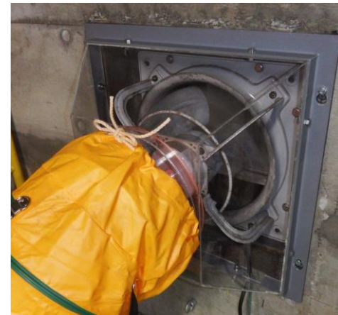
接続用アダプタとフレキシブルダクトの接続状態
