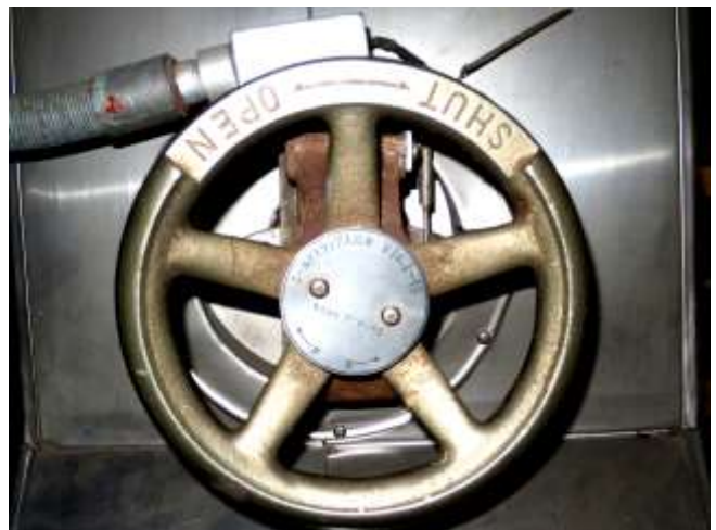
第5図 保守点検における誤操作防止
