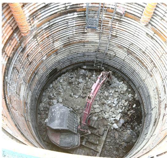
図 2.7.2-31 掘削状況写真
