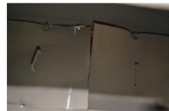
盤内仕切板の状態 (母線室-遮断器室間)
