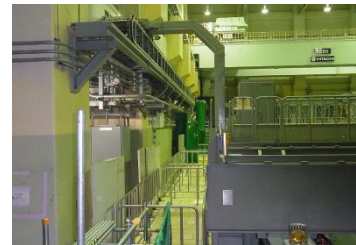
原子炉建物壁面
