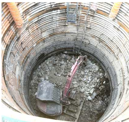
図 2.7.2-30 掘削状況写真
