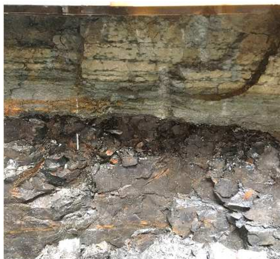
図 2.7.2-31 掘削面の近接写真
