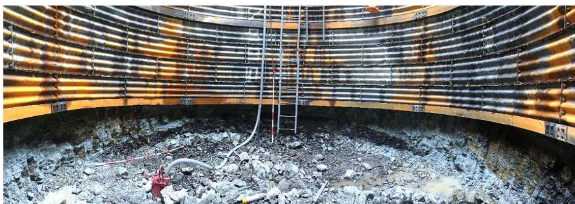
図 2.7.2-29 島根サイトの深礎杭 掘削面の写真 (南側)
