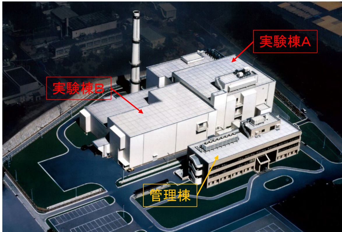
原子炉建家(実験棟A及び実験棟B)外観
