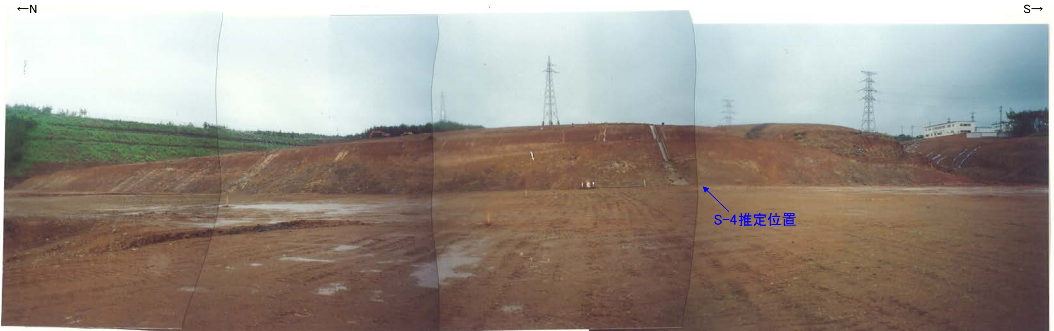
写真(2号機建設時)
