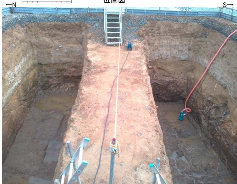
トレンチ状況写真(西側から撮影)
