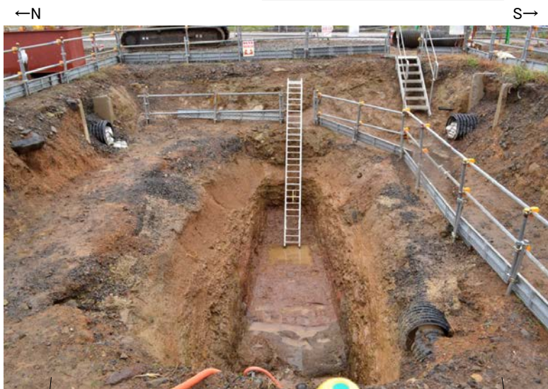
トレンチ全景写真(西側から撮影)
