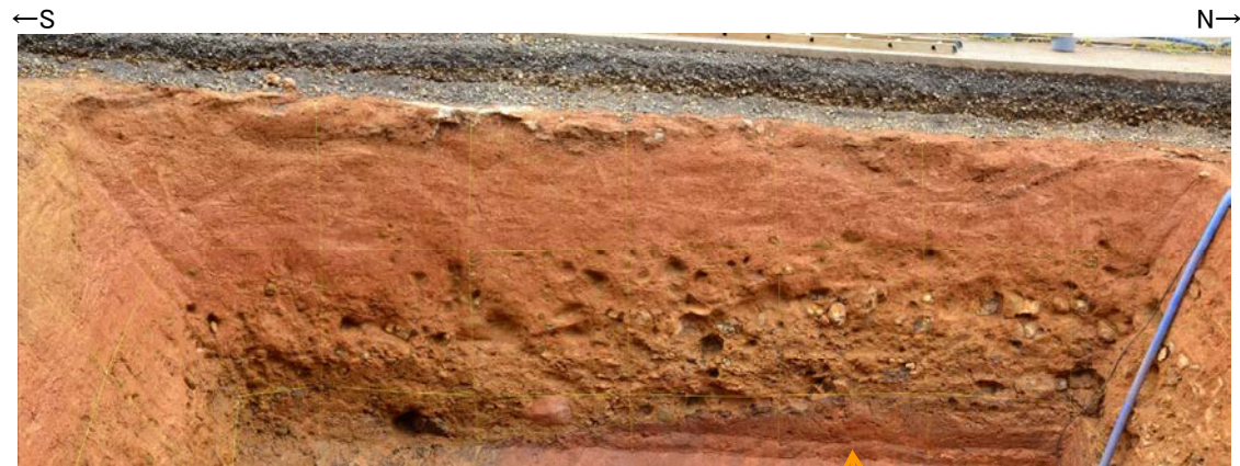
写真(駐車場南東方トレンチ 西壁面)
