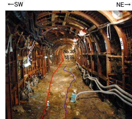
横坑の状況写真 (立坑側より, 2013年撮影)
