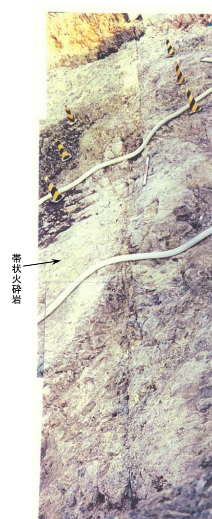
原子炉建屋底盤(EL-7.1m) S-1付近 写真
