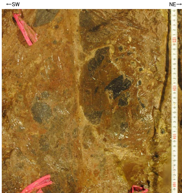
No.29付近底盤写真
