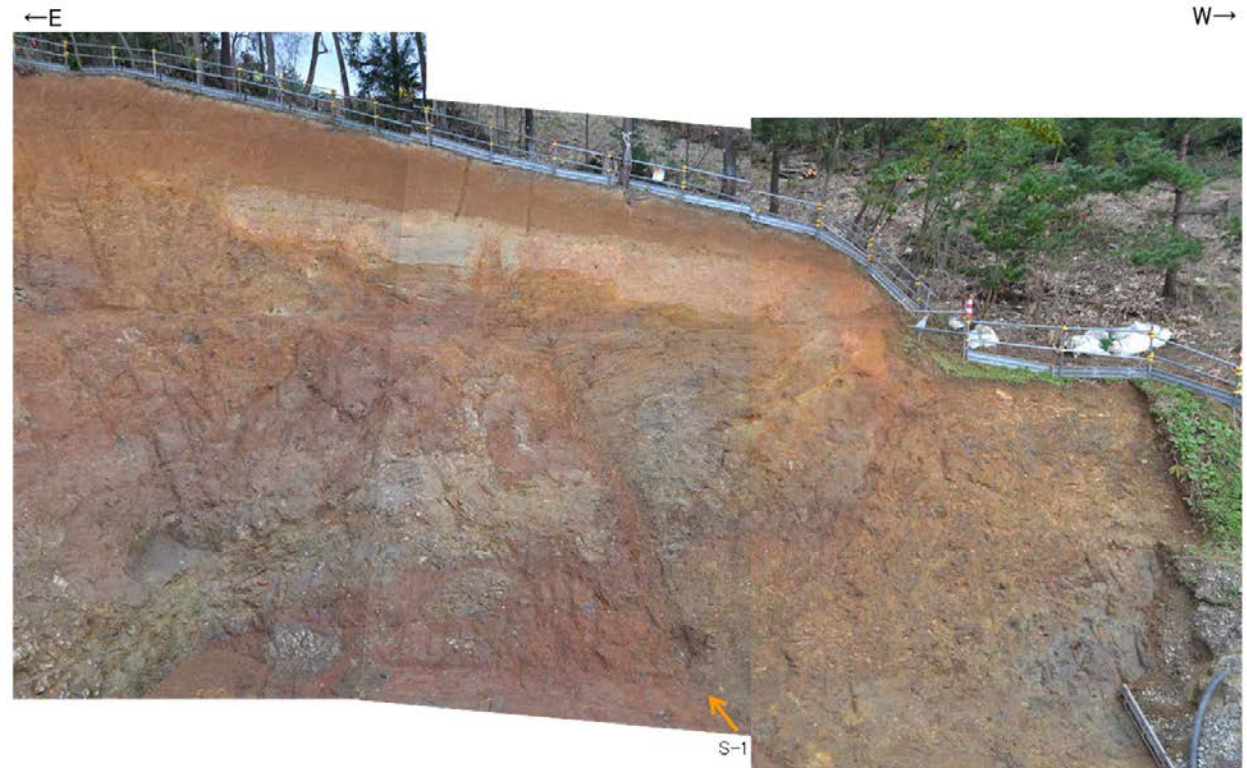
法面写真(南側法面)
