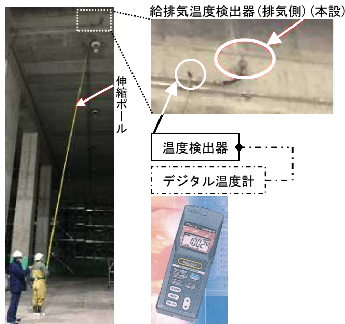
給排気温度の代替計測用計測器
