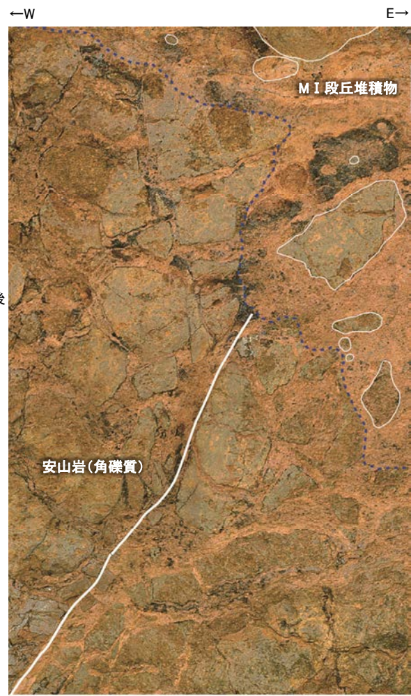
※写真, 境界は再整形後のもの 再整形後拡大写真(当初観察面より約10cm掘り込み)
