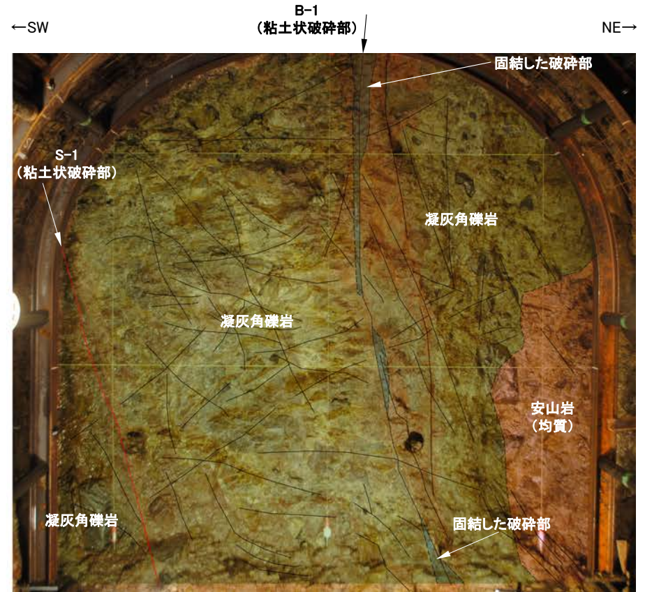
No.15切羽写真(割れ目等を加筆)
