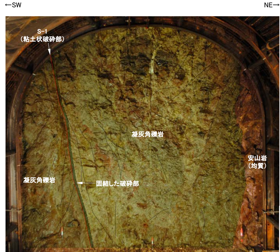
No.30切羽写真(割れ目等を加筆)
