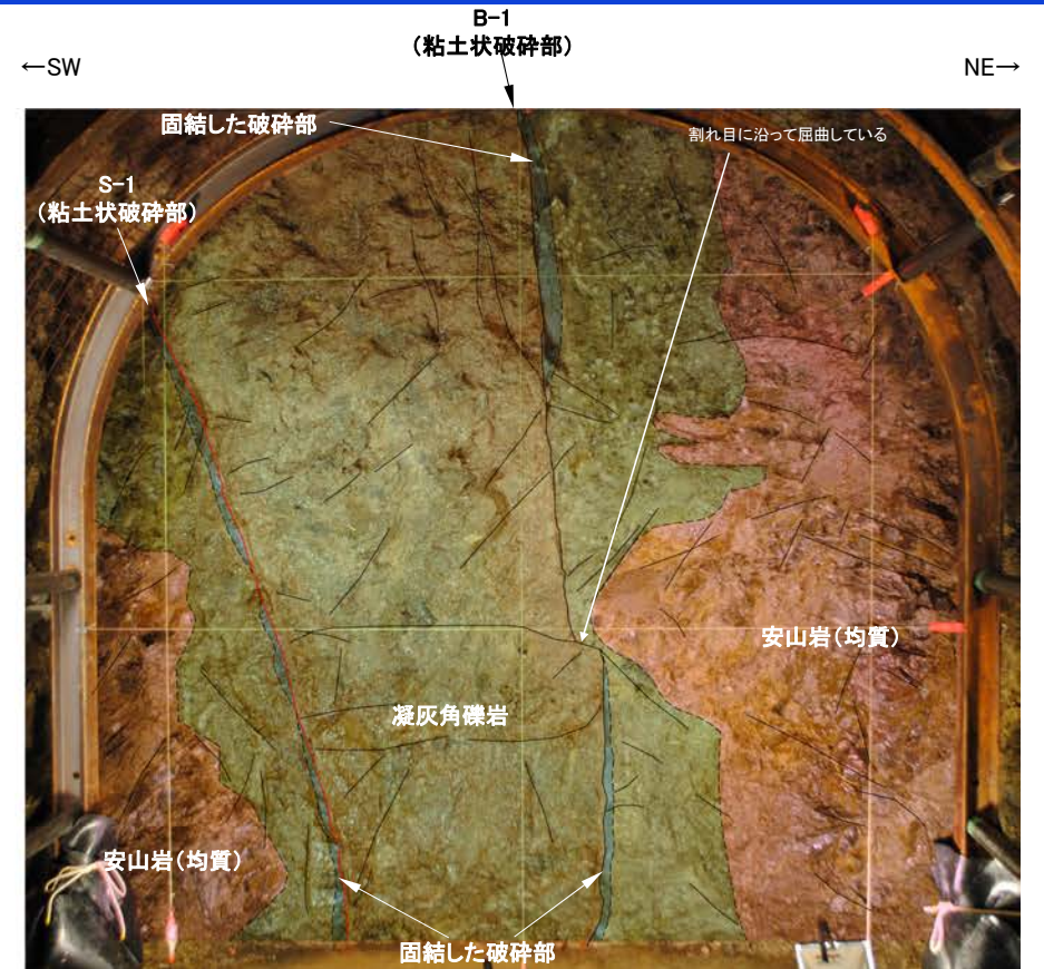
No.8切羽写真(割れ目等を加筆)
