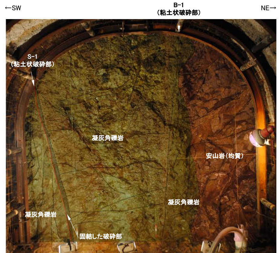
No.26切羽写真(割れ目等を加筆)
