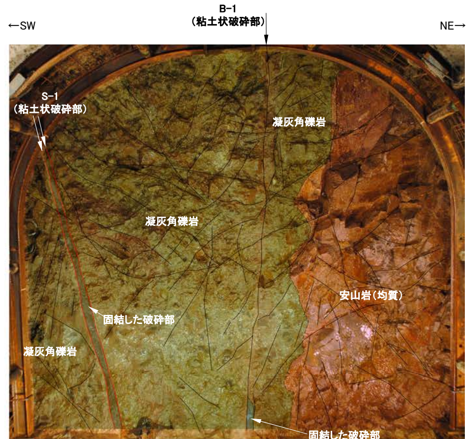
No.24切羽写真(割れ目等を加筆)
