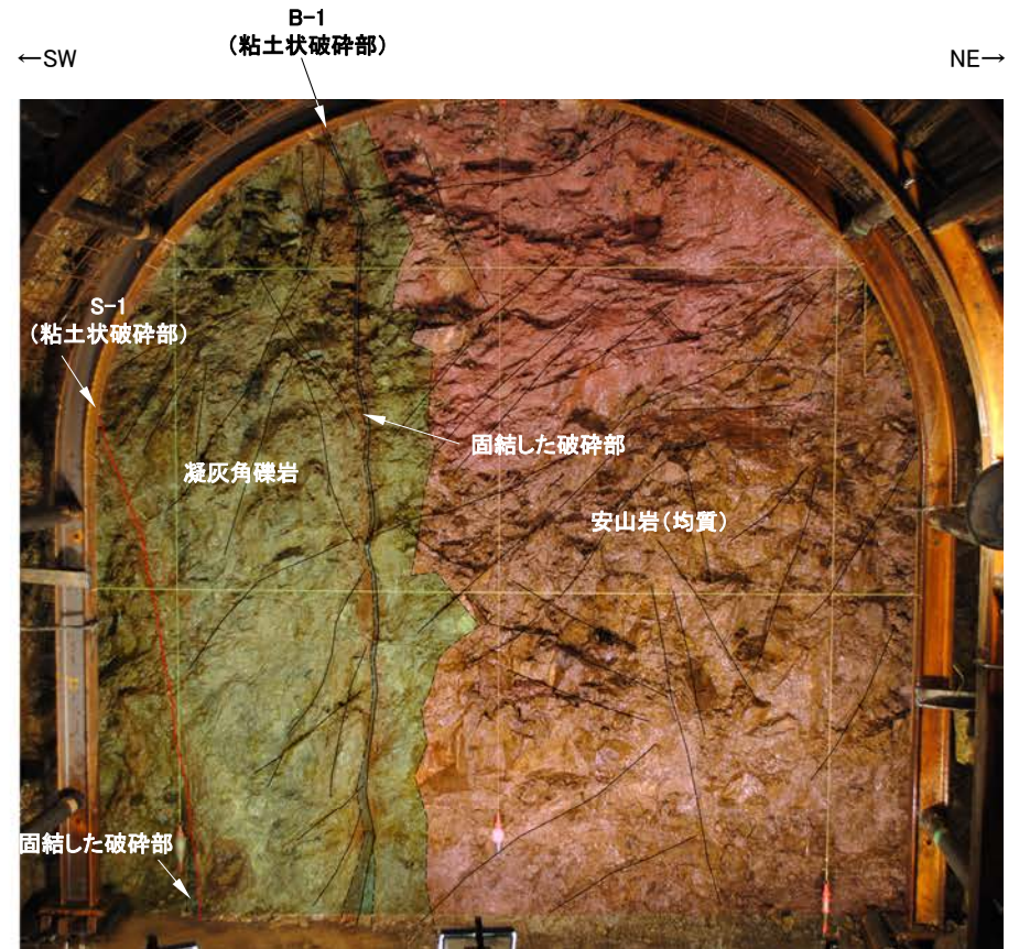
No.5切羽写真(割れ目等を加筆)
