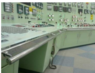
手摺設置状況
