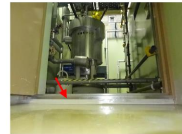
図4-1 漏えい油の拡大の防止対策の例
