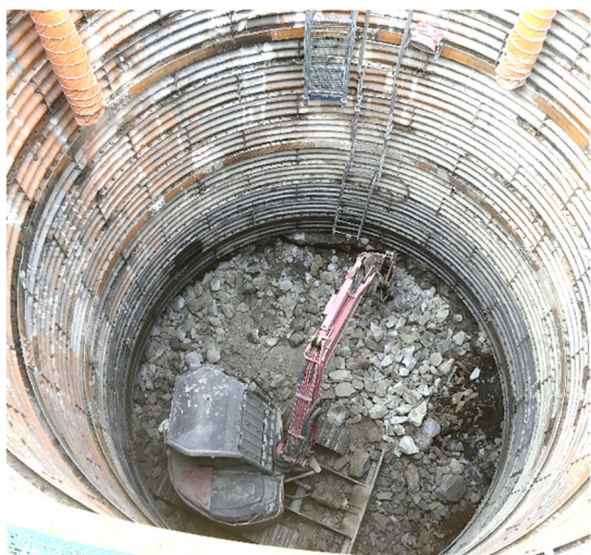
図 2.7.2-25 掘削状況写真
