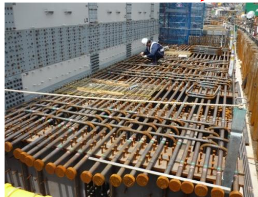
フーチング組立状況
