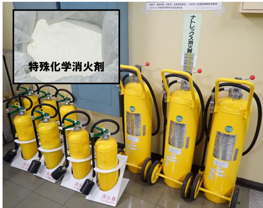
特殊化学消火剤を装填した可搬式消火器
