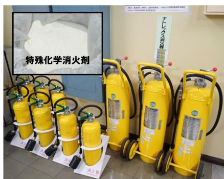
第 1.1 図 特殊化学消火剤を装填した可搬式消火器
