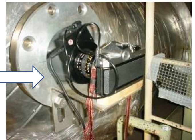
検査孔 (検査時)
