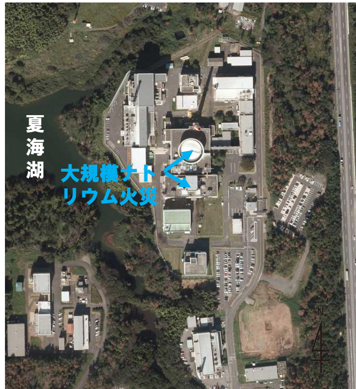
高速実験炉部（「常陽」現場対応班） 大規模ナトリウム火災への対応を実施
