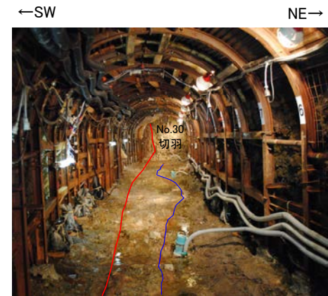
S-1 B-1 横坑の状況写真 (立坑側より, 2013年撮影)
