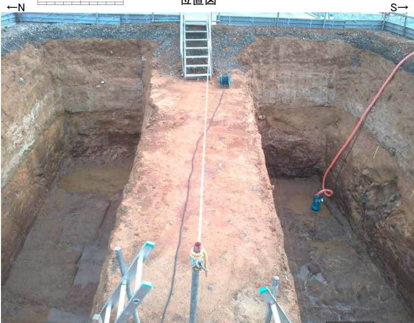
トレンチ状況写真(西側から撮影)
