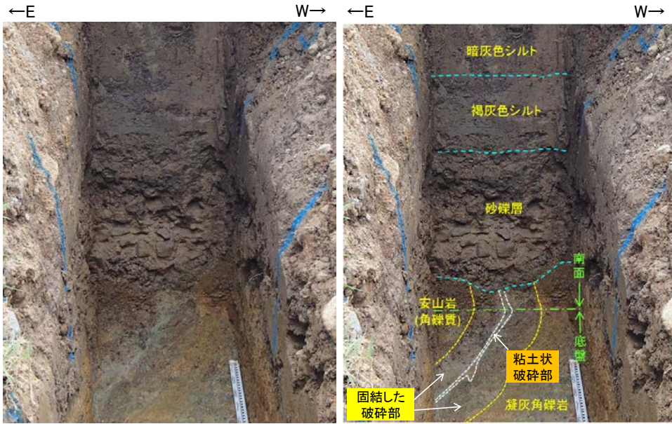
南面 拡大写真
