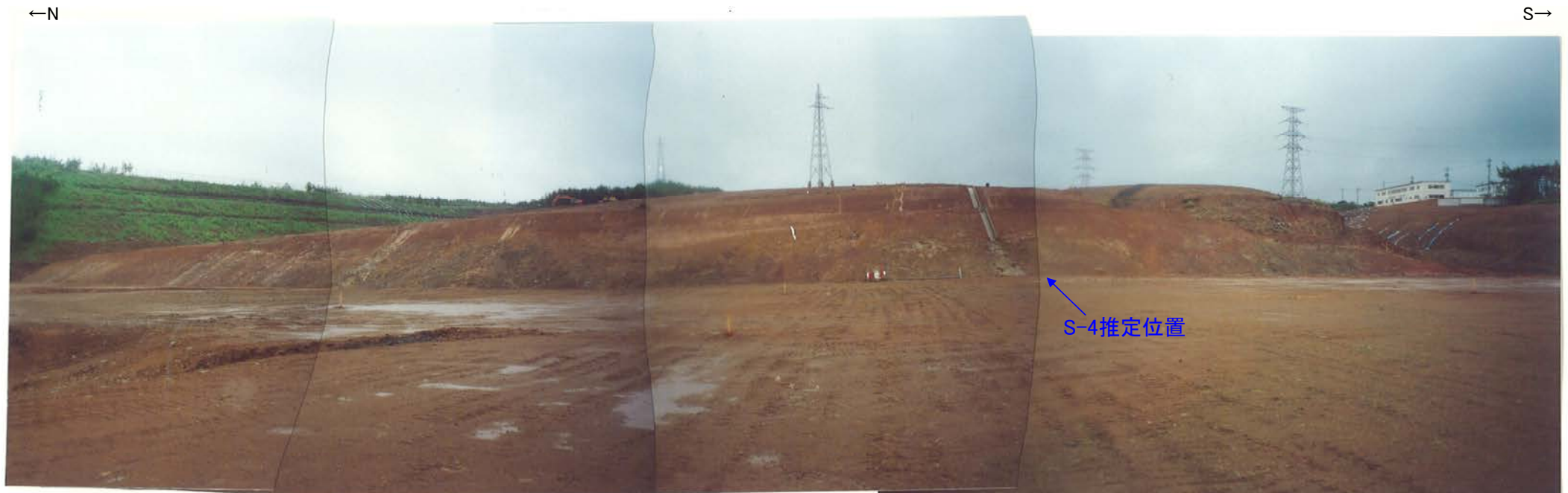
写真(2号機建設時)
