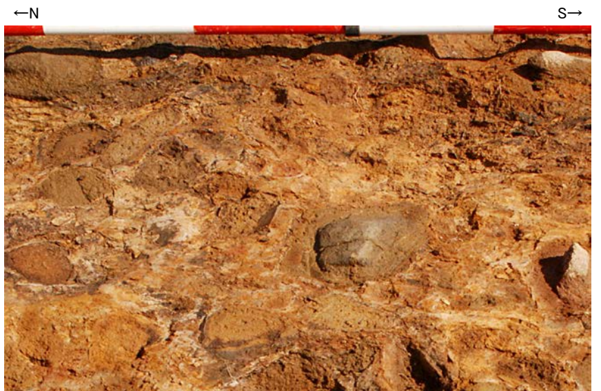
35m盤法面 堆積物の拡大写真
