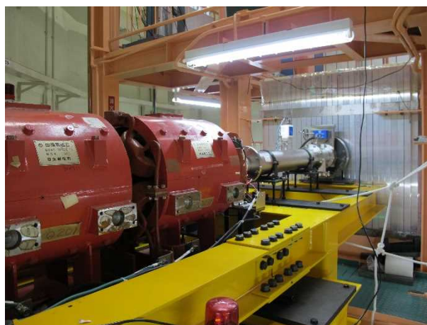
図 B-5 中性子発生設備（電磁石からターゲット方向を見たところ）
