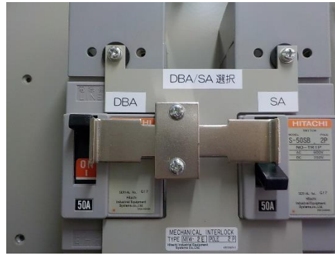
第2図 機械式インターロックの例
