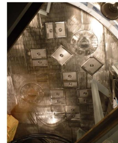
図 1-3 コリウムシールド外観
