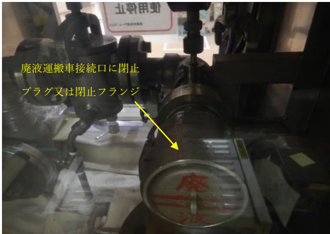
図 4.1 廃液運搬車接続口の閉止イメージ
