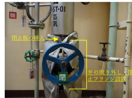
③ 弁を取り外して閉止フランジを設置するか、フランジ面間に閉止板を挿入する。
