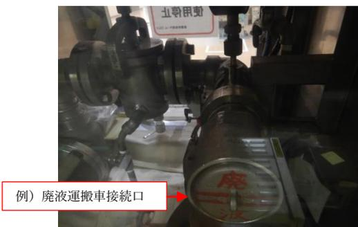
① 廃液の受入口に閉止プラグ又は閉止フランジを設置する。
