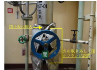
③ 弁を取り外して閉止フランジを設置するか、フランジ面に閉止板を挿入する。
