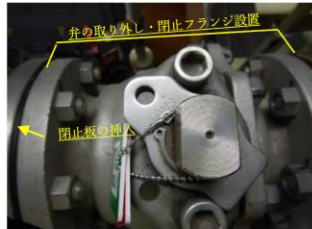
② 弁を取り外して閉止フランジを設置するか、フランジ面に閉止板を挿入する。
