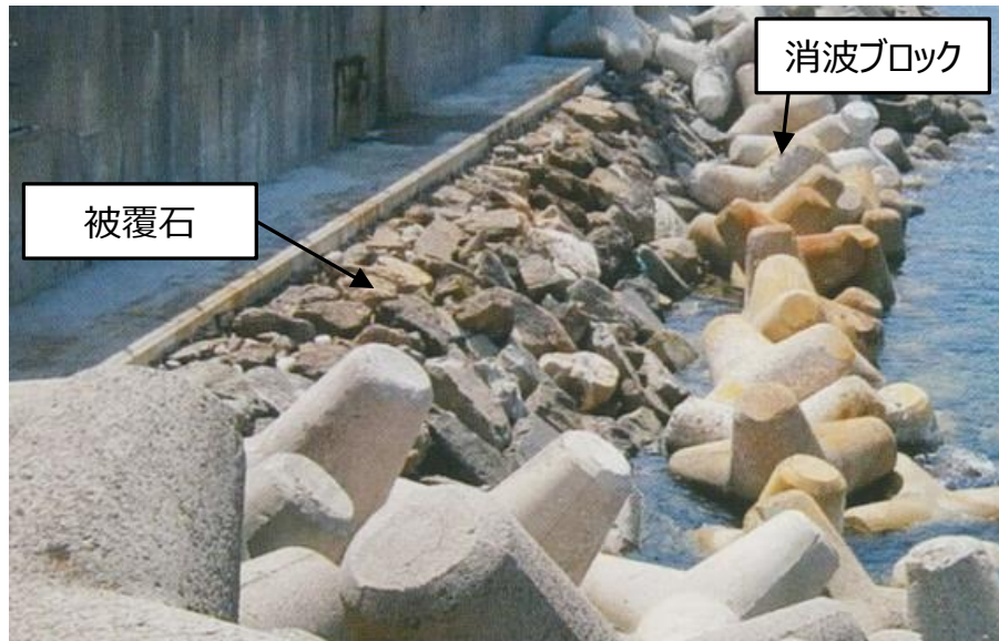
被覆石の設置状況（1，2号機北側護岸）
