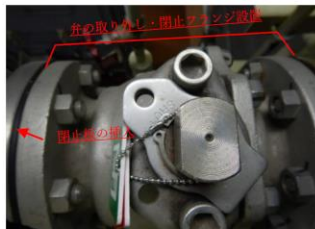
② 弁を取り外して閉止フランジを設置するか、フランジ面に閉止板を挿入する。
