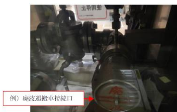
① 廃液の受入口に閉止プラグ又は閉止フランジを設置
