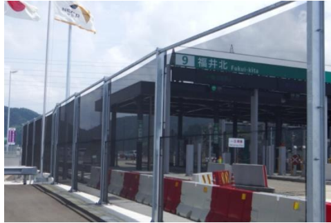
防風用高性能樹脂シートの設置例
