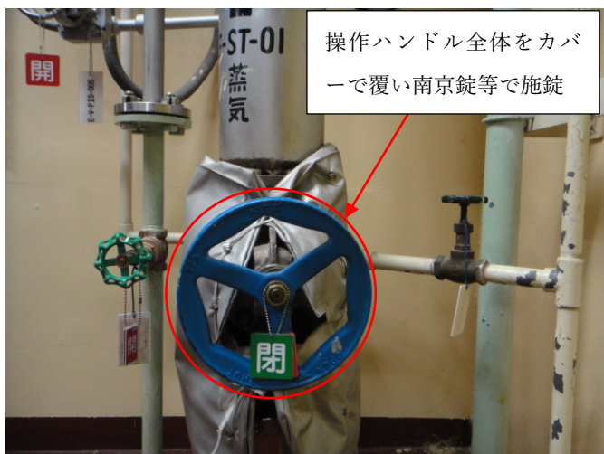
図 4.3 弁の施錠イメージ (加熱蒸気)
