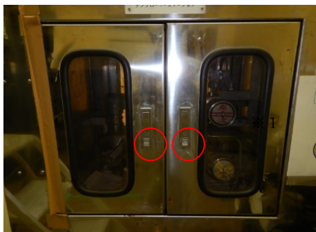
① 廃液の受入口（タンクローリーステーション）の扉を施錠
