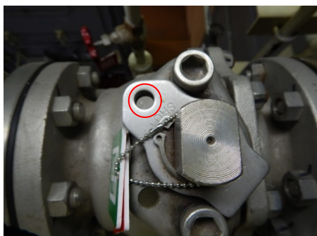
② 弁棒側の穴と弁体側の穴を合わせて南京錠等で施錠
