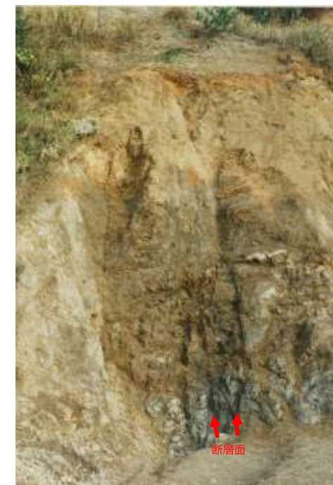
36H01断層 露頭写真
