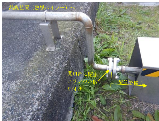
図 4.3 閉止フランジによる閉止イメージ
