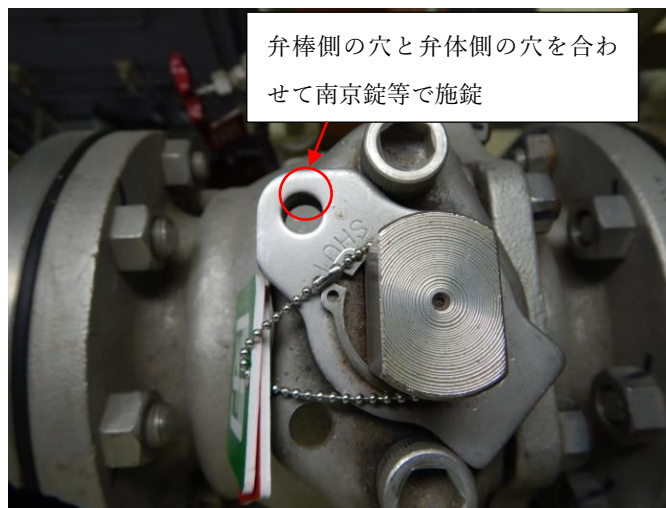
図 4.2 弁の施錠イメージ
