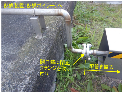
① LPG配管を閉止フランジで閉止
